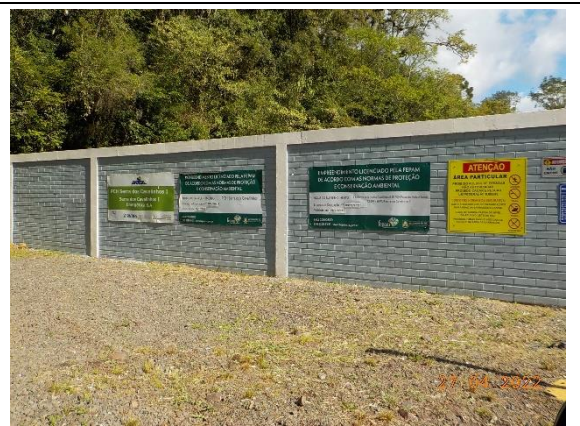
Foto 2. Portão principal de acesso (PCH Serra dos Cavalinhos I) e placas de divulgação do licenciamento ambiental.
