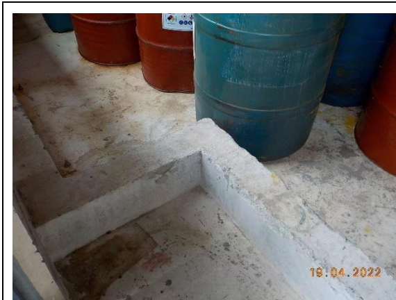
Foto 7. Bacia de contenção.
