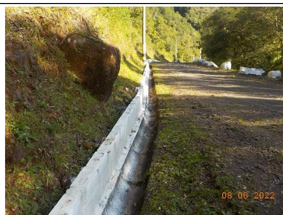
Foto 2. Vala de drenagem em acesso interno – PCH Passo do Meio.
