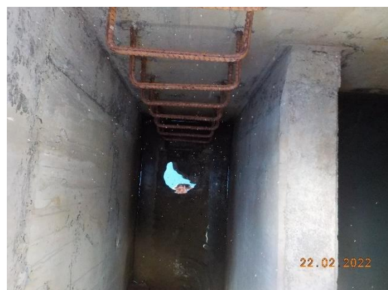
Foto 28. Inspeção no SSAO da PCH Serra dos Cavalinhos II.
