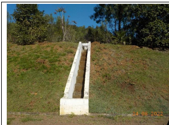
Foto 1. Escada dissipadora de energia – PCH Pezzi.
