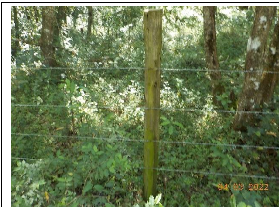
Foto 1. Reparos realizados no cercamento da APP (ponto 2).
