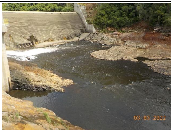
Foto 2. Inspeção de jusante nas PCHs do Complexo Antas.
