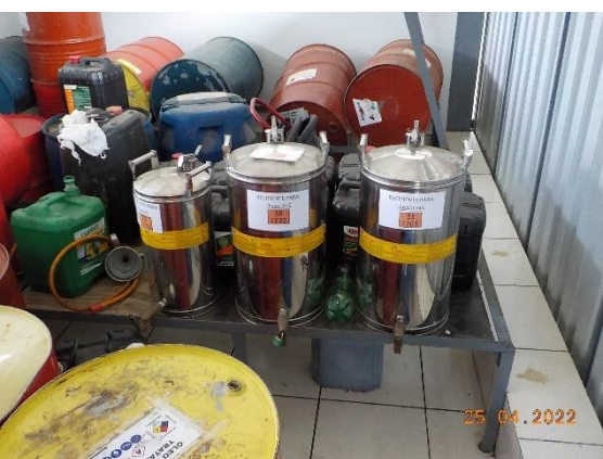
Foto 24. Armazenamento temporário de resíduos classe I (óleos).
