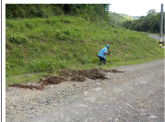
Foto 3. Limpeza e manutenção das canaletas de drenagem na PCH Passo do Meio.
