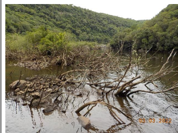
Foto 13. Inspeção no fim do reservatório.
