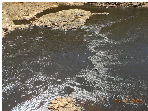
Foto 3. Inspeção de jusante nas PCHs do Complexo Antas.
