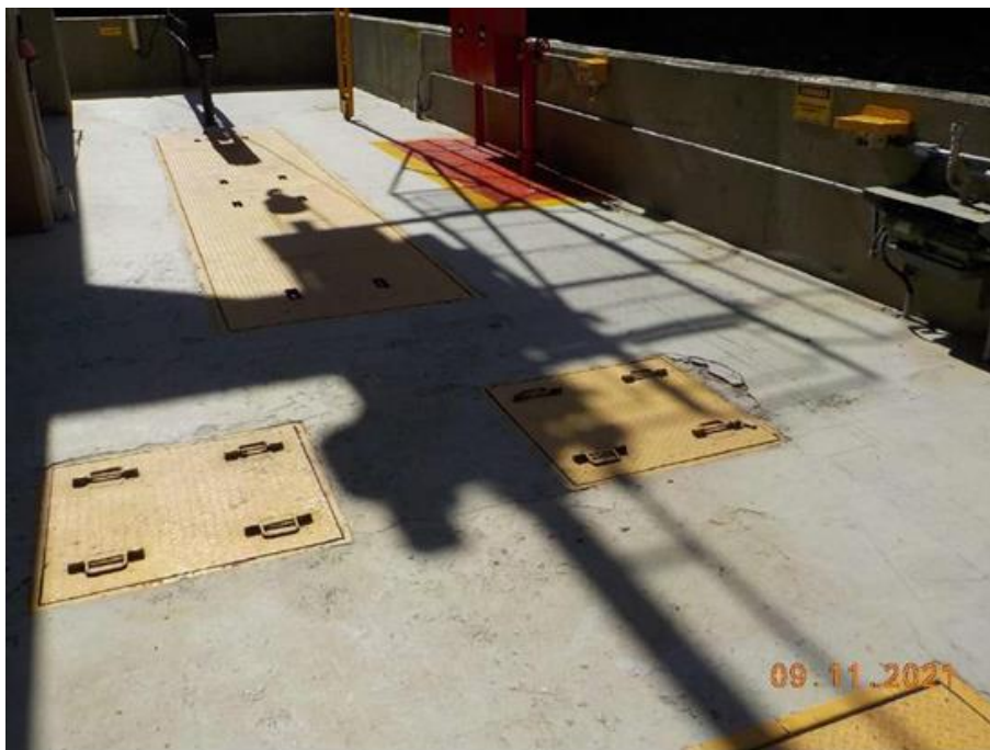
Foto 3-4. Sistema de tratamento de efluente - PCH Serra dos Cavalinhos II.
