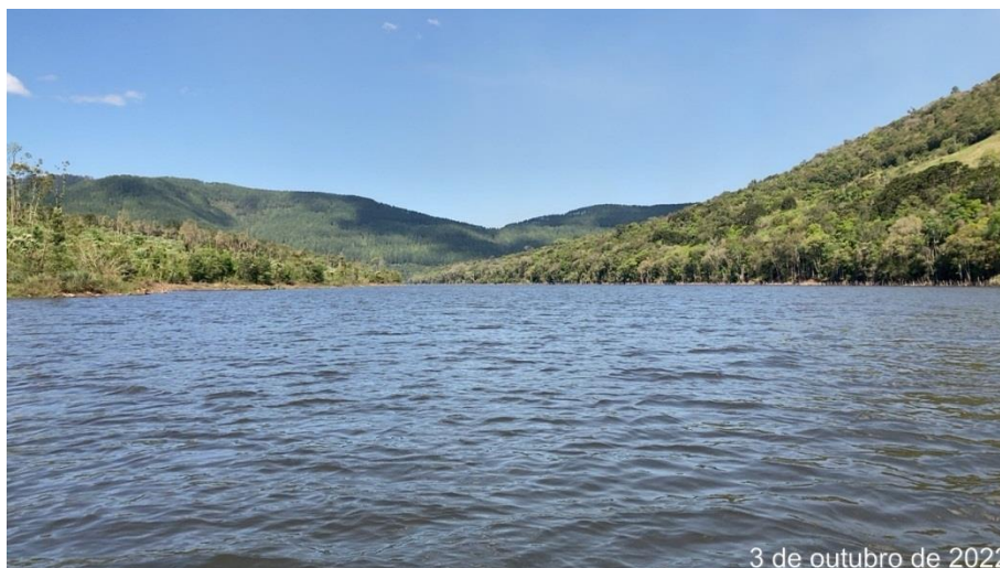
Figura 5-3. Visão geral no ponto 02.
