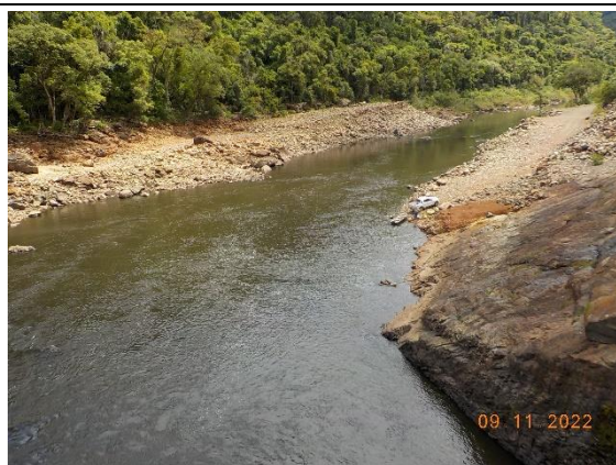
Foto 1. Inspeção de jusante nas PCHs do Complexo Antas.
