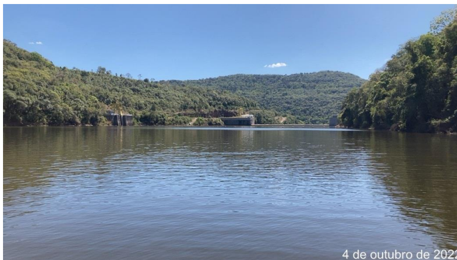
Figura 5-5. Visão geral no ponto 04.
