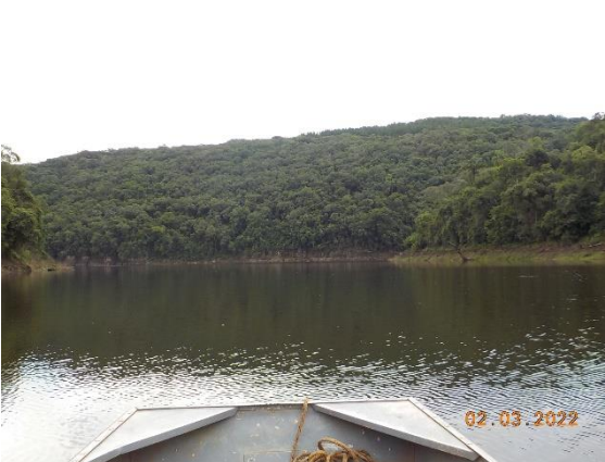
Foto 10. Vista geral do reservatório da PCH Passo do Meio.
