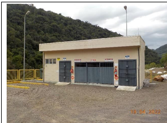
Foto 1. Depósito de Produtos Químicos e Contaminantes – PCH Serra dos Cavalinhos I.
