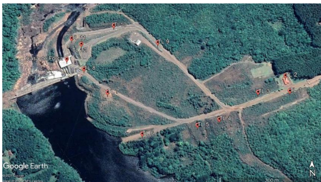
Figura 2. Locais de monitoramento dentro do site da PCH Pezzi.
