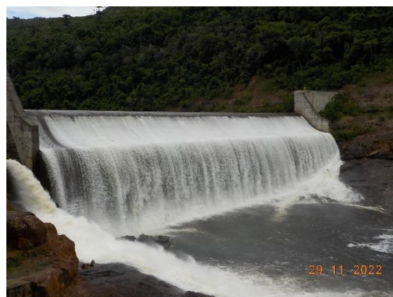
Foto 4. Inspeção de jusante nas PCHs do Complexo Antas.
