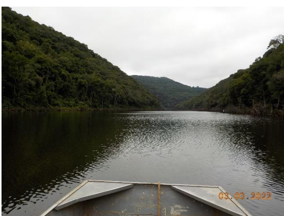
Foto 14. Visão geral do reservatório da PCH Serra dos Cavalinhos I.
