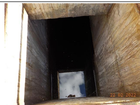
Foto 26. Inspeção no SSAO da PCH Passo do Meio.
